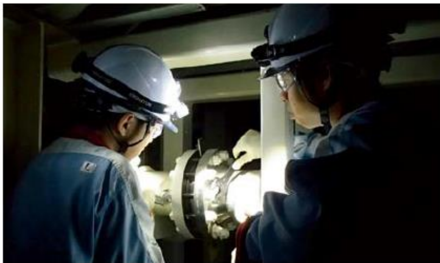
配管接続訓練
