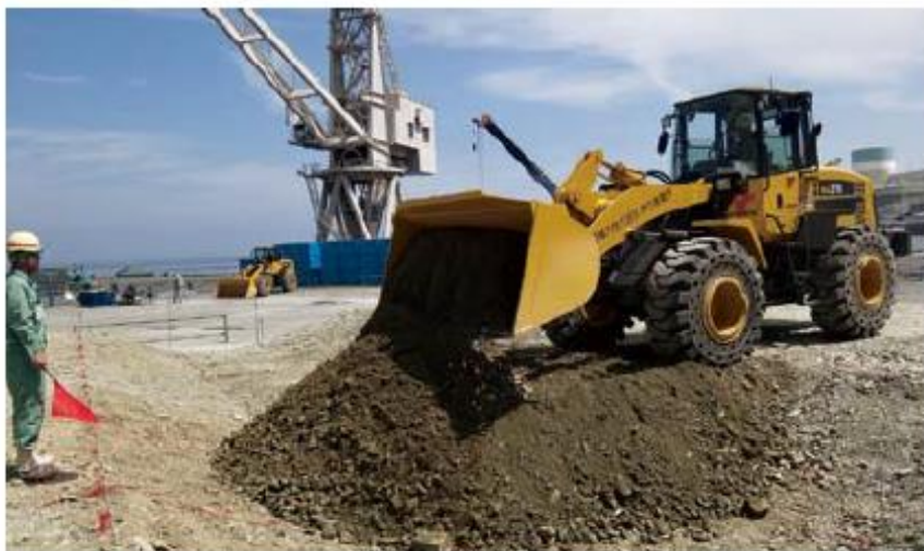
ホイールローダでの陥没箇所修復訓練
