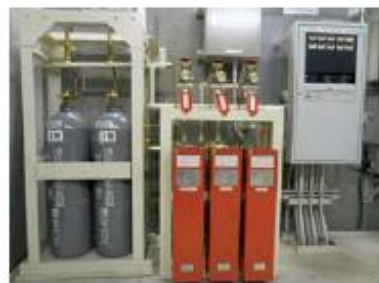
自動消火装置(ハロン消火装置)
