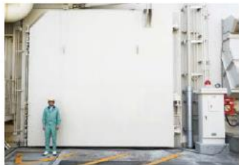
大型水密扉(扉の厚さ35cm)
