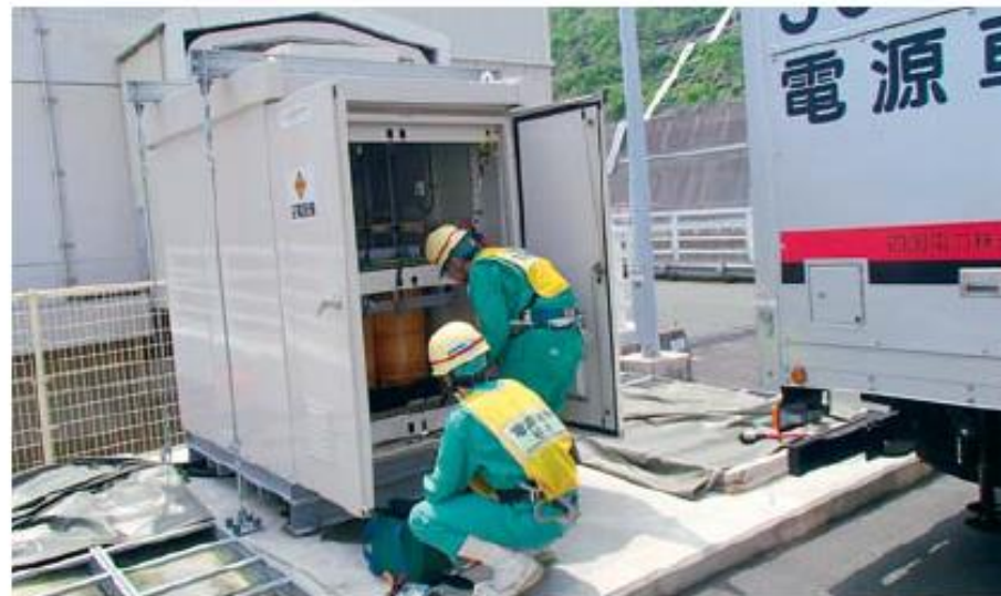
電源車から建屋への給電訓練
