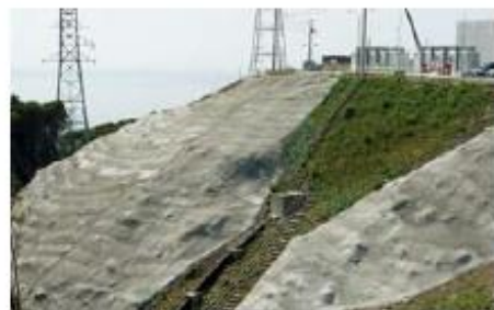
周辺約35mの樹木を伐採しモルタルを吹付
