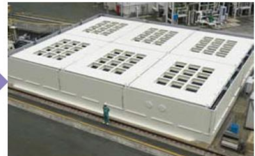
海水ピットポンプ室防護壁を設置 (飛来物対策後)
