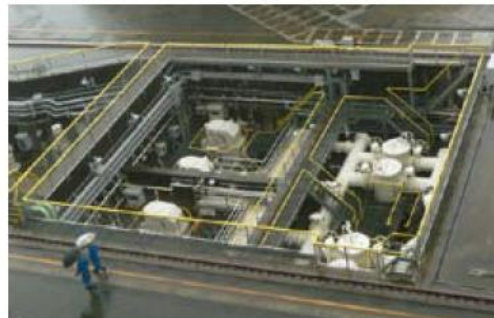
海水ピットポンプ室 (飛来物対策前)
