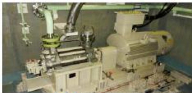
④ 蒸気発生器代替注水ポンプ
